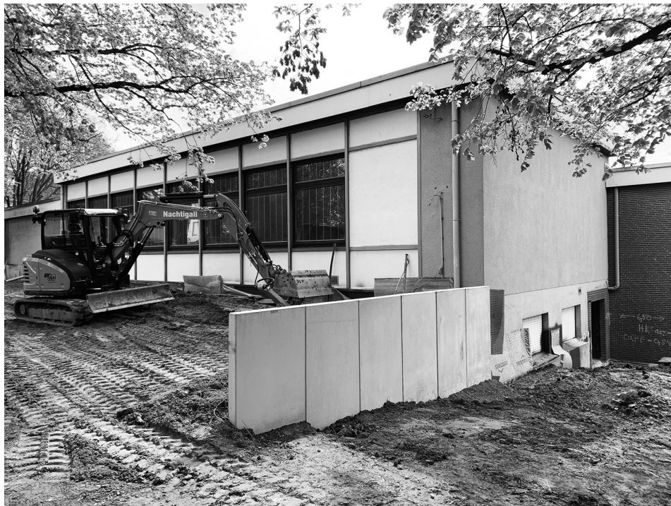
...auf der Baustelle ist einiges geschehen
